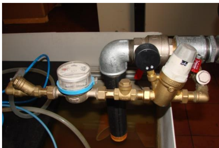
Fig. 10 Bransamentul dispozitivului de injectie
